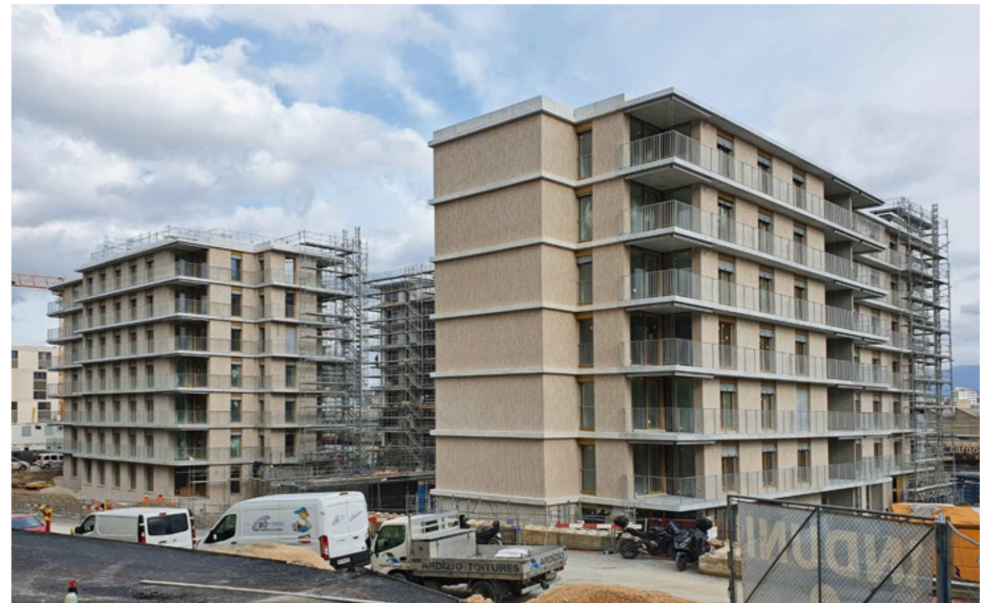
Les derniers bâtiments des lots D et E seront achevés pour cet été. Ne manquera plus que l'école pour que le quartier soit pleinement opérationnel.
